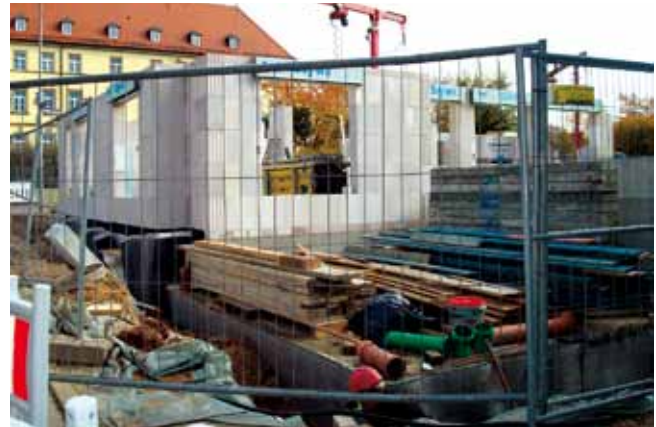
Das Erdgeschoss nimmt Formen an.
